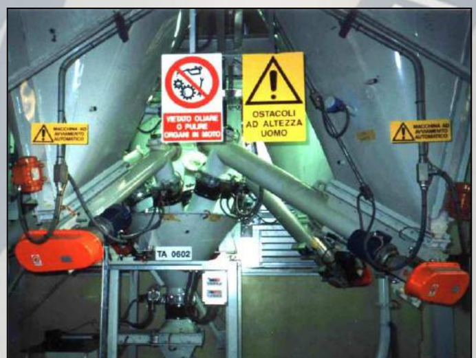
Serbatoio bilancia. Weigher tank
