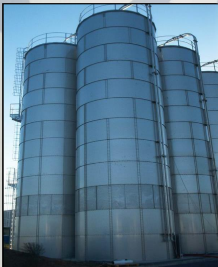
Sili su gonna. Storage bins on support.
