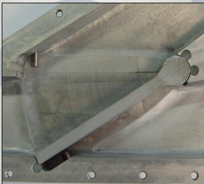
Particolare delle tenute sulla bandinella. Band-shaped gasket
