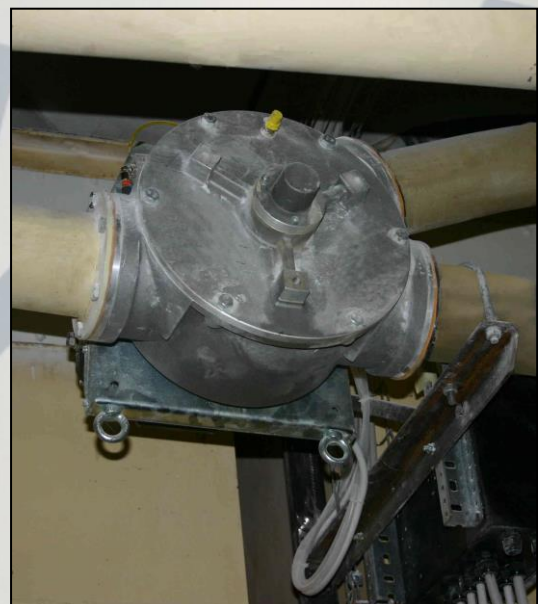
Valvola deviatrici a tamburo. Drum diverter
